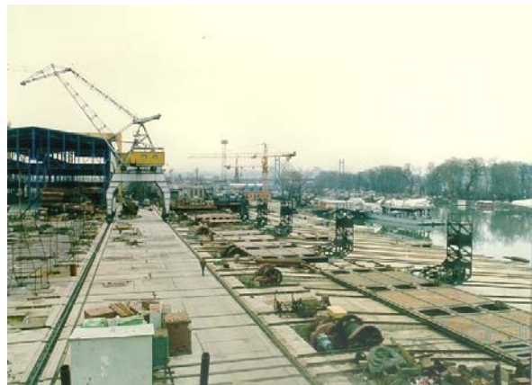
Slika 5 - Jedan od navoza za izvlačenje brodova koji je projektovan u Odeljenju za brodogradnju
